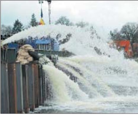
Mit mehreren Hochleistungspumpen des Typs Hannibal fördert das THW mehr als 25 000 Liter Wasser pro Minute über eine Spundwand.
